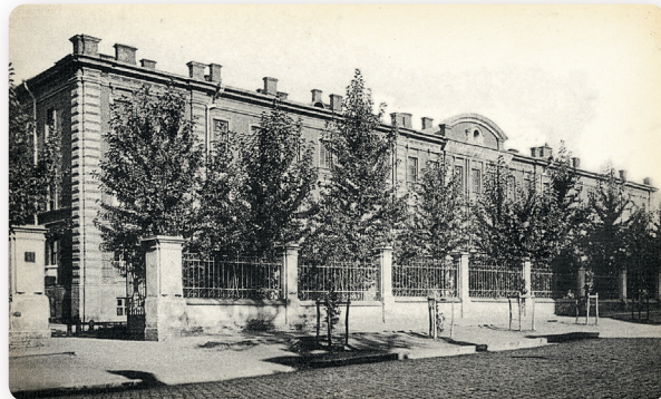
Лабораторний корпус медичного факультету. Вул. Сумська, 41 (не зберігся)
